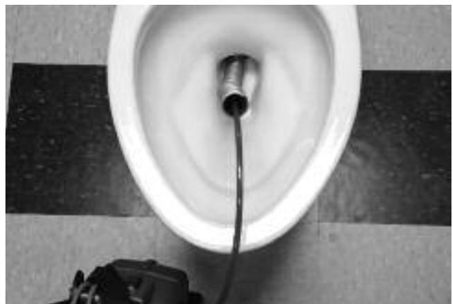
**Abbildung 25 – Verwendung eines Führungsschlauchs**
